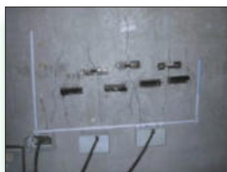
Мониторинг развития трещин в бетоне
