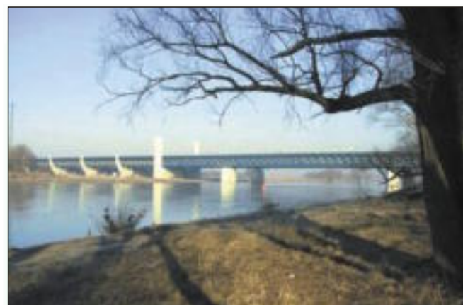
Длительный мониторинг состояния мостовых конструкций
